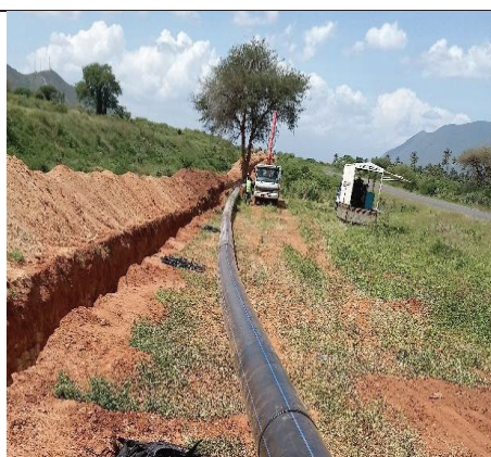
Picha namba 9-6: Mtaru wa Bomba la Maji ulioachwa wazi bila kuwa na alama za zuio la kiusalama.
