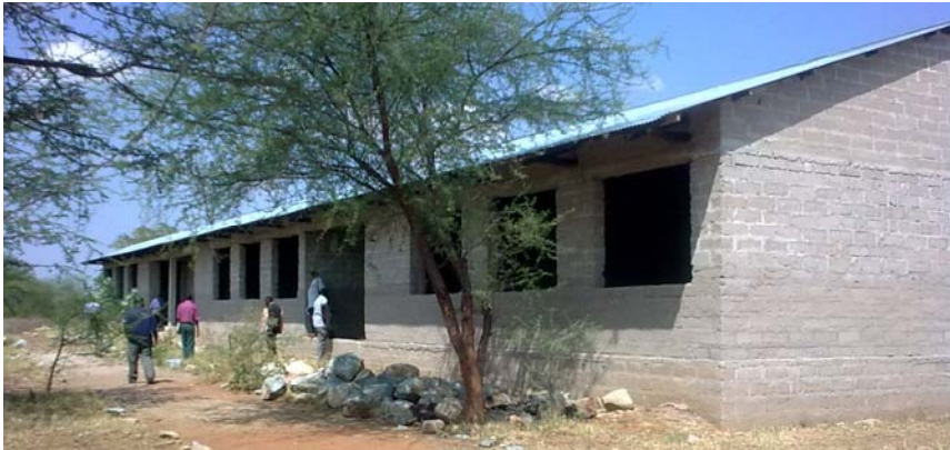
Jengo la Maabara shule ya Sekondari Songwa kama linavyoonekana nje
