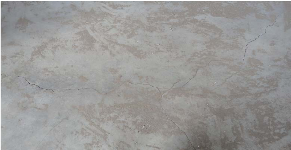
Sakafu katika shule ya sekondari ukenyenge iliyojengwa chini ya kiwango
