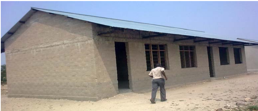
Jengo la madarasa mawili katika Shule ya sekondari Igaga ambalo bado halijakamilika
