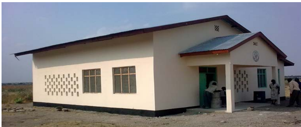
Jengo la Idara ya wagonjwa wa nje (OPD) katika zahanati ya kisesa
