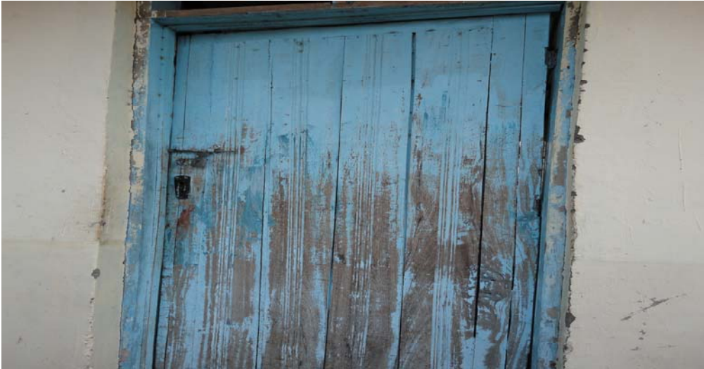
Mlango katika shule ya sekondari ukenyenge ulitengezwa chini ya kiwango
