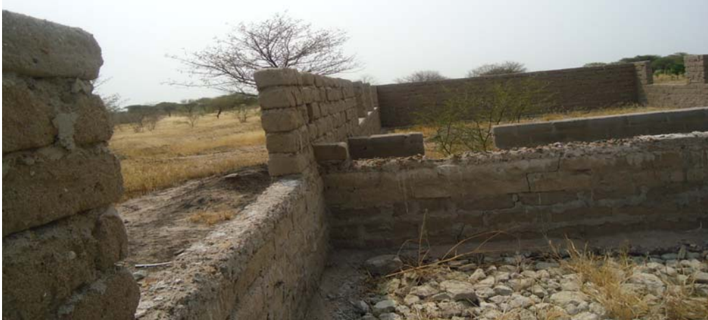
Sehemu ya jengo la maabara katika shule ya sekondari Mwamashele
