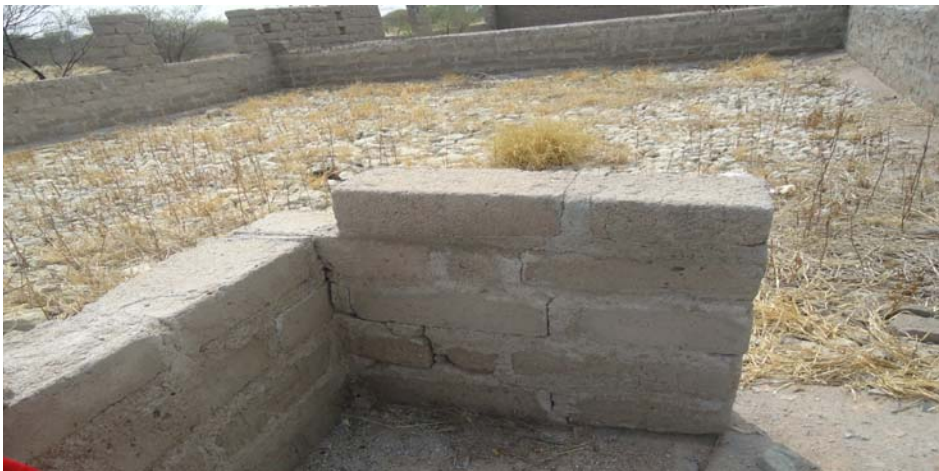
Sehemu ya jengo la maabara katika shule ya sekondari Mwamashele
